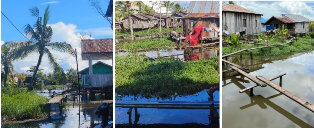
Gambar 2. Kondisi Jaringan Jalan Rumah di Atas Rawa
